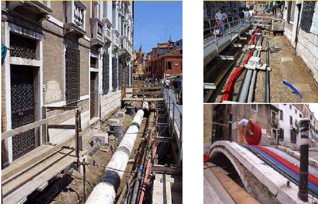
Fig. 1 Lavori di manutenzione e stesura della fibra
